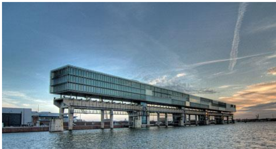
Kantoorgebouw Kraanspoor in Amsterdam
